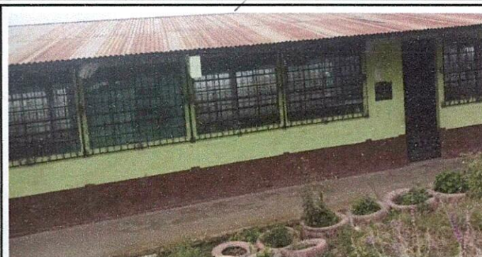
Foto 2: Mejoramiento de pintura
