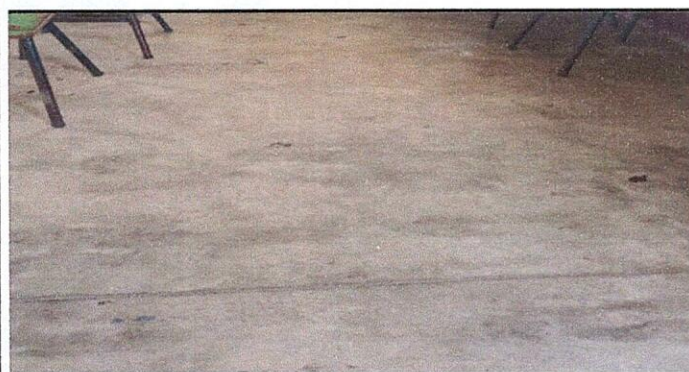
Foto 5: Mejoramiento de piso ceramico
